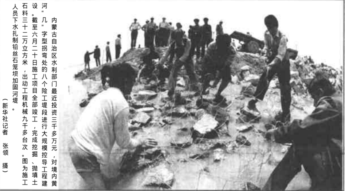
内蒙古自治区水利部最近投资三千多万元,对境内黄河几字型拐弯处的八个险工险段进行大规模控导工程。截至六月二十日,施工项目全部竣工,完成挖槽、抛填土石料三十二万立方米,出动工程机械九十多台次。图为施工人员下河扎制铅丝石笼坝加固河堤。(新华社记者 张领 摄)
